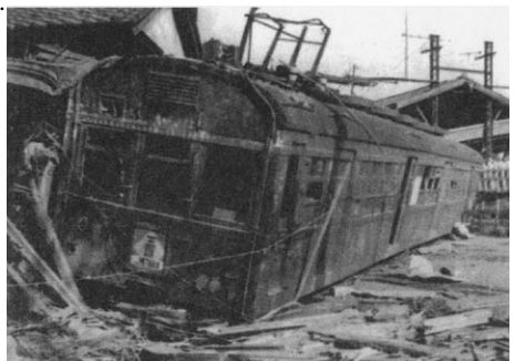
事故現場の状況
